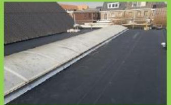
EPDM dak met lichtstraat
