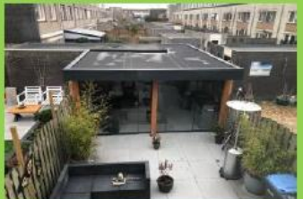
Douglas overkapping / EPDM dak + isolatie
